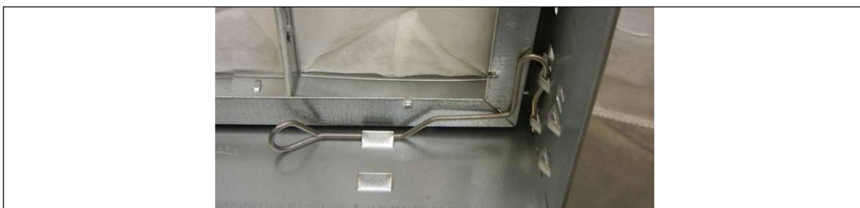
Fig. 69 Telaio di montaggio dei filtri - Supporto per filtro, destra
