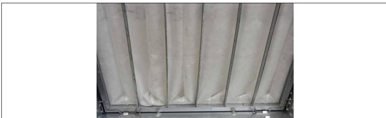
Fig. 70 Telaio di montaggio dei filtri con supporti per filtri
