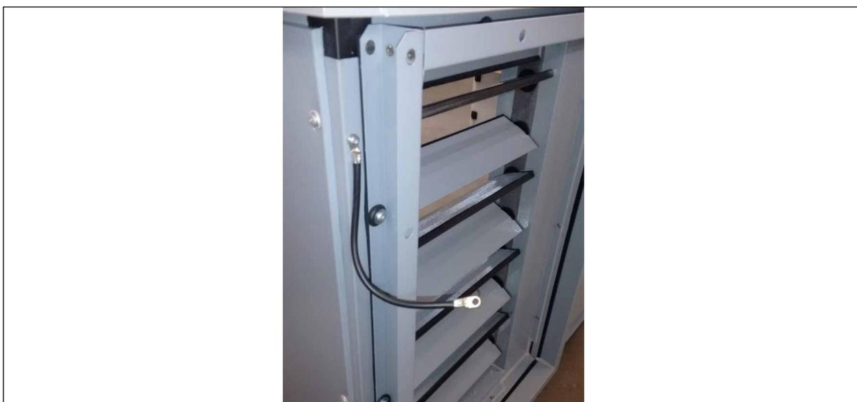
Fig. 6 Collegamento equipotenziale sul lato unità
