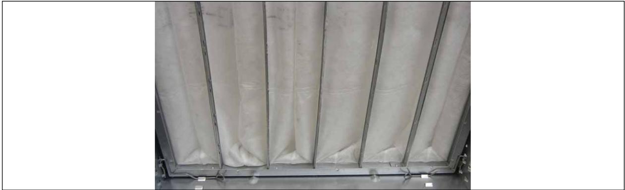
Fig. 79 Cadre de montage du filtre avec pinces pour filtre
