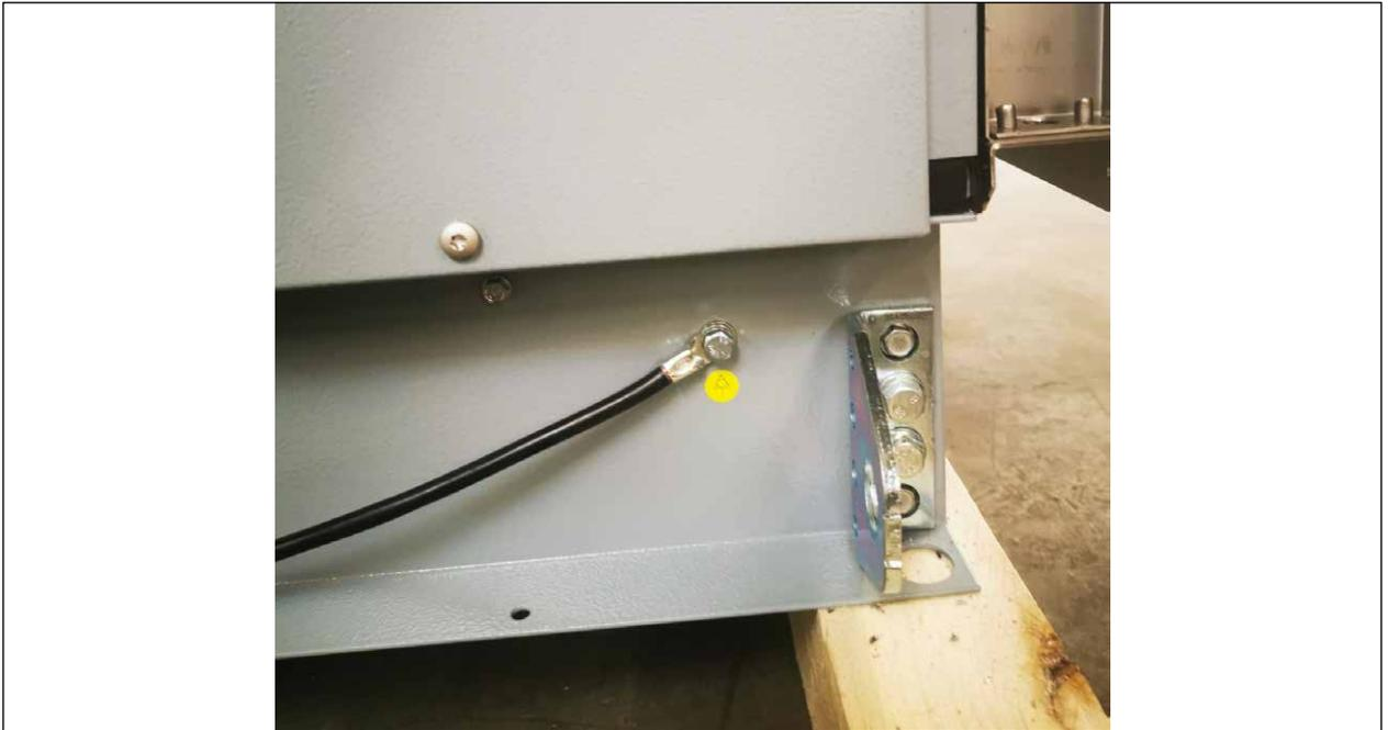
Fig. 15 Raccordement de potentiel au cadre de base
