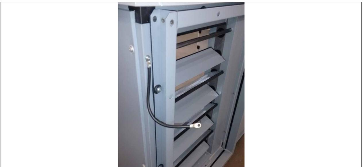
Fig. 16 Liaison équipotentielle appliquée sur l'appareil
