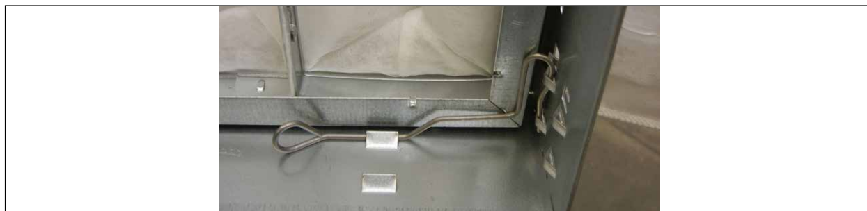
Fig. 69 Cadre de montage du filtre avec pince pour filtre droite
