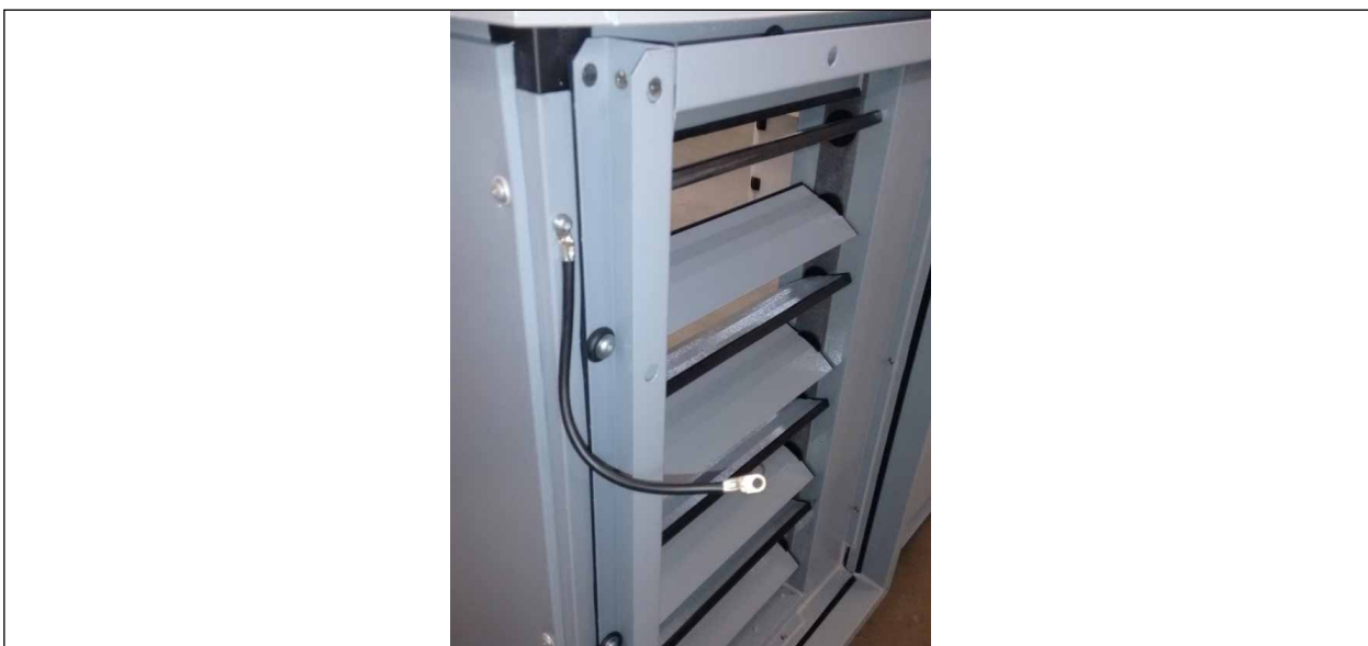
Fig. 6 Liaison équipotentielle appliquée sur l'appareil
