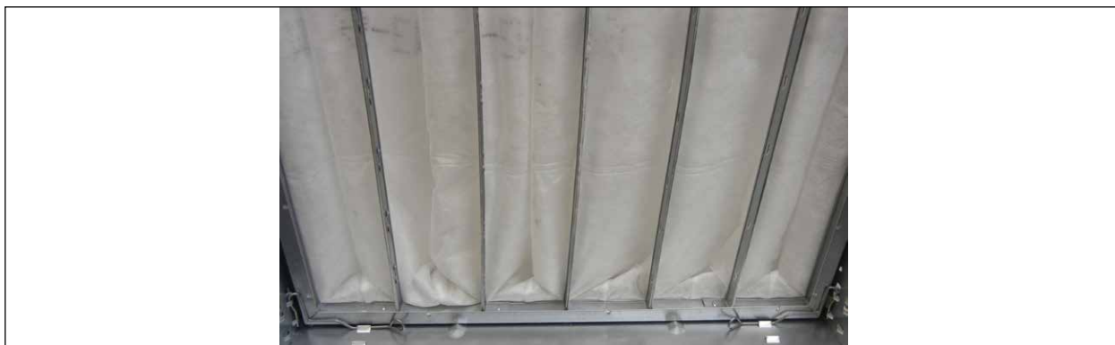
Rys. 70 Ramka mocująca filtra z klamrami filtra
