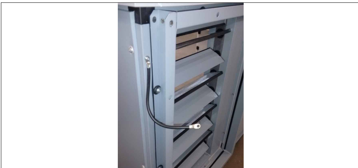
Rys. 6 Wyrównanie potencjałów umieszczone po stronie urządzenia
