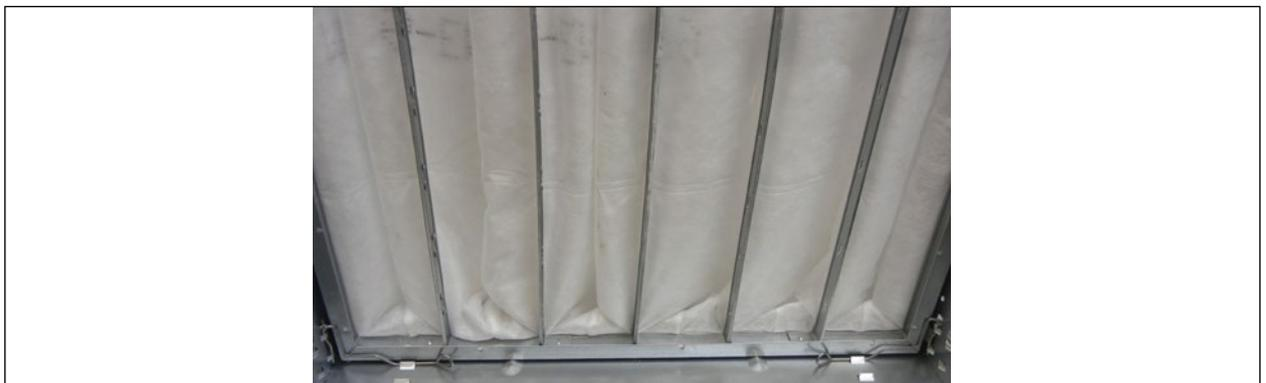
Abb. 67 Filteraufnahmerahmen mit Filterklammern
