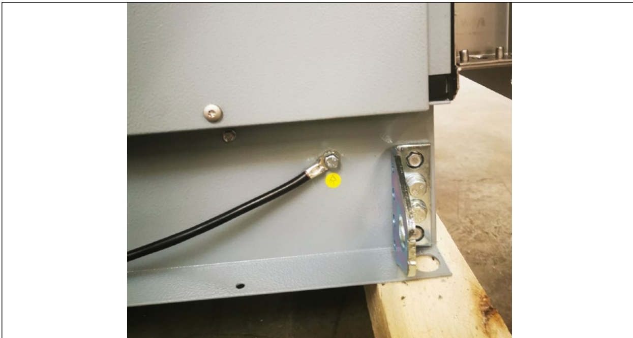
Abb. 15 Potentialanschluss am Grundrahmen
