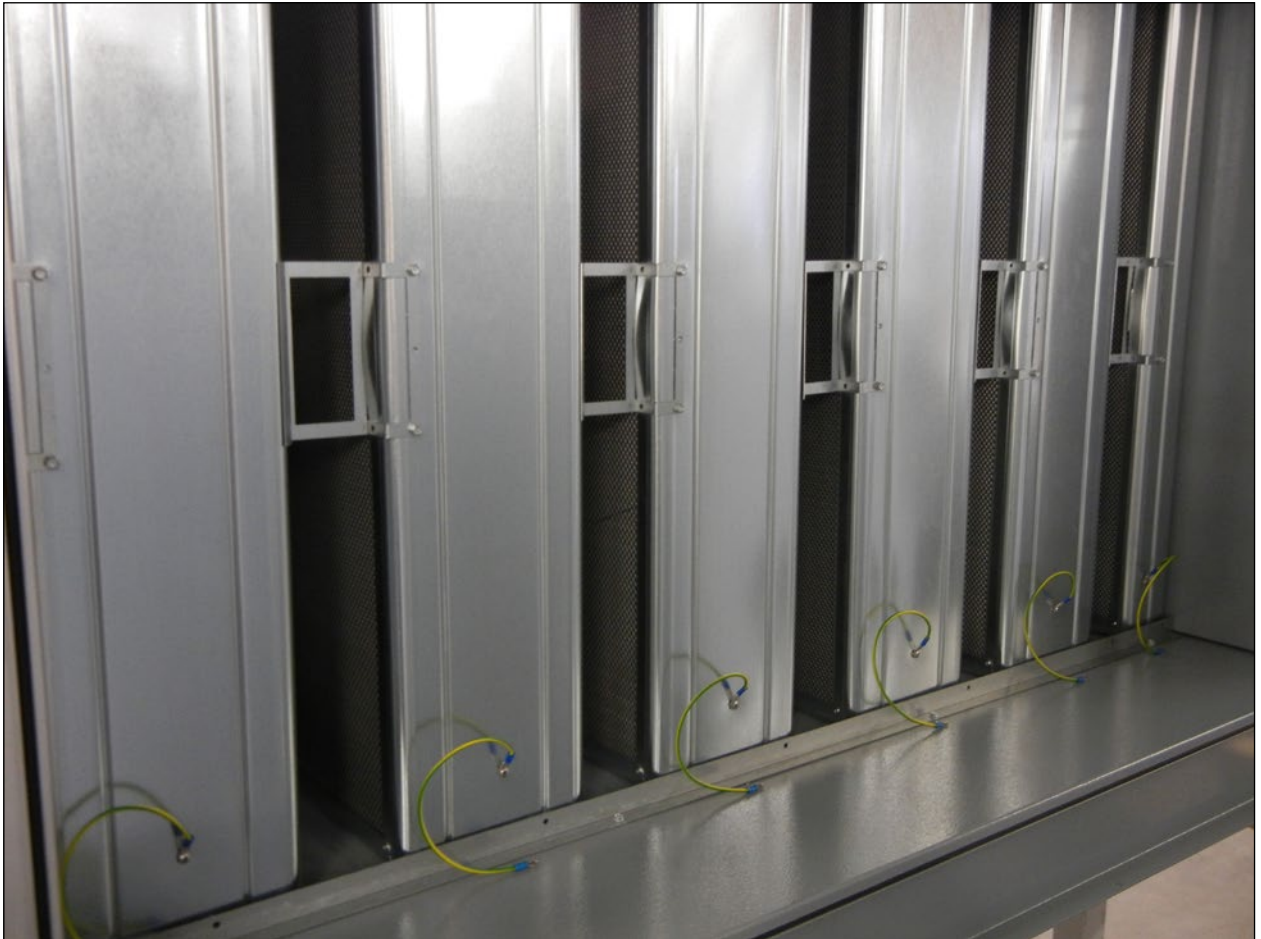
Abb. 66 Mehrere Schalldämpferkulissen mit Potentialausgleich
