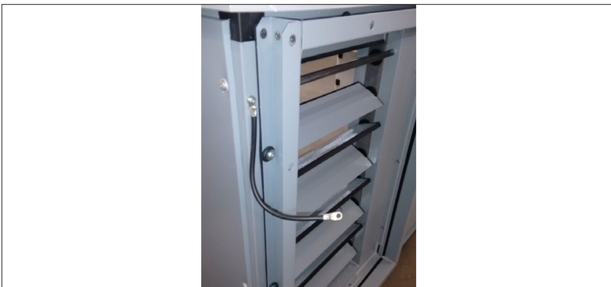
Abb. 16 Geräteseitig angebrachter Potentialausgleich
