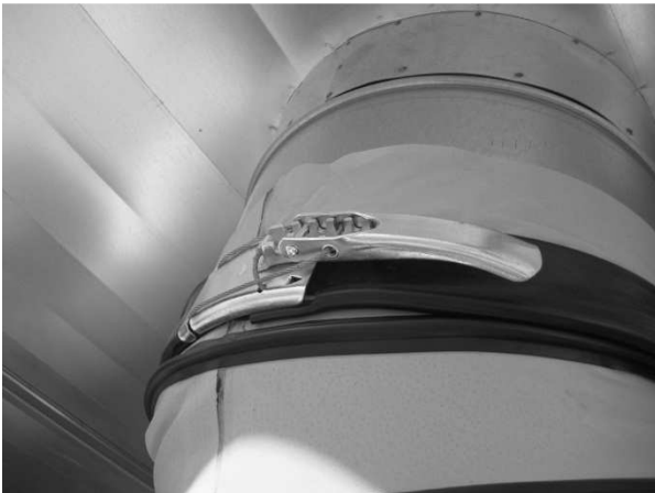
Abb.: Montage Spannschelle
