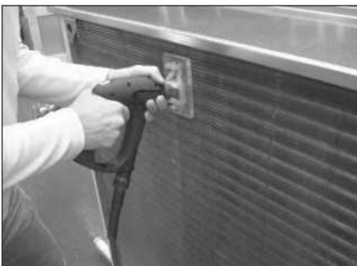
Abb.: THD-Mehrstrahlverfahren (Vorderseite)
