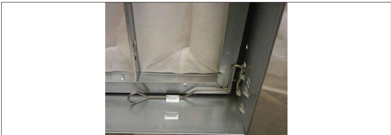
Abb. 78 Filteraufnahmerahmen Filterklammer rechts
