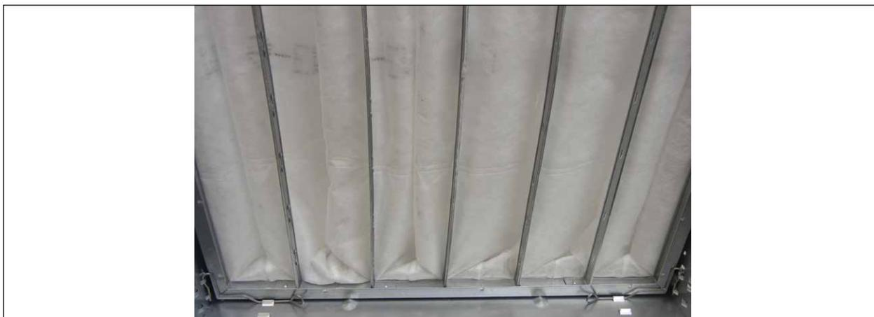
Abb. 79 Filteraufnahmerahmen mit Filterklammern
