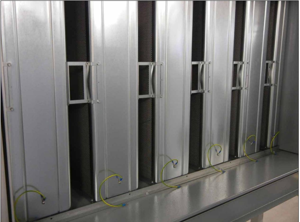
Abb. 66 Mehrere Schalldämpferkulissen mit Potentialausgleich
