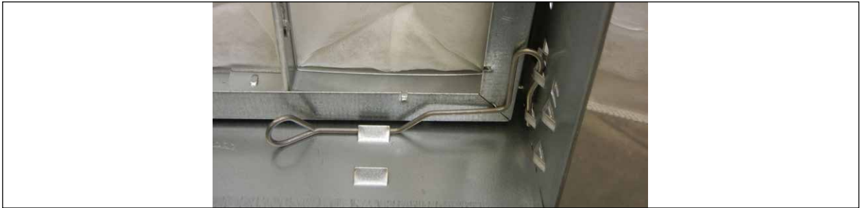
Afb. 78 Filteropnameframe filterklem rechts
