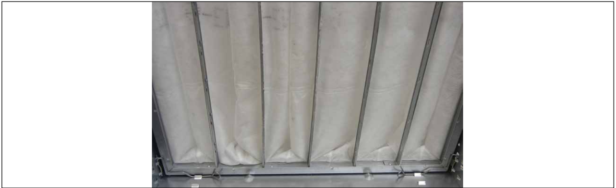
Afb. 79 Filteropnameframe met filterklemmen
