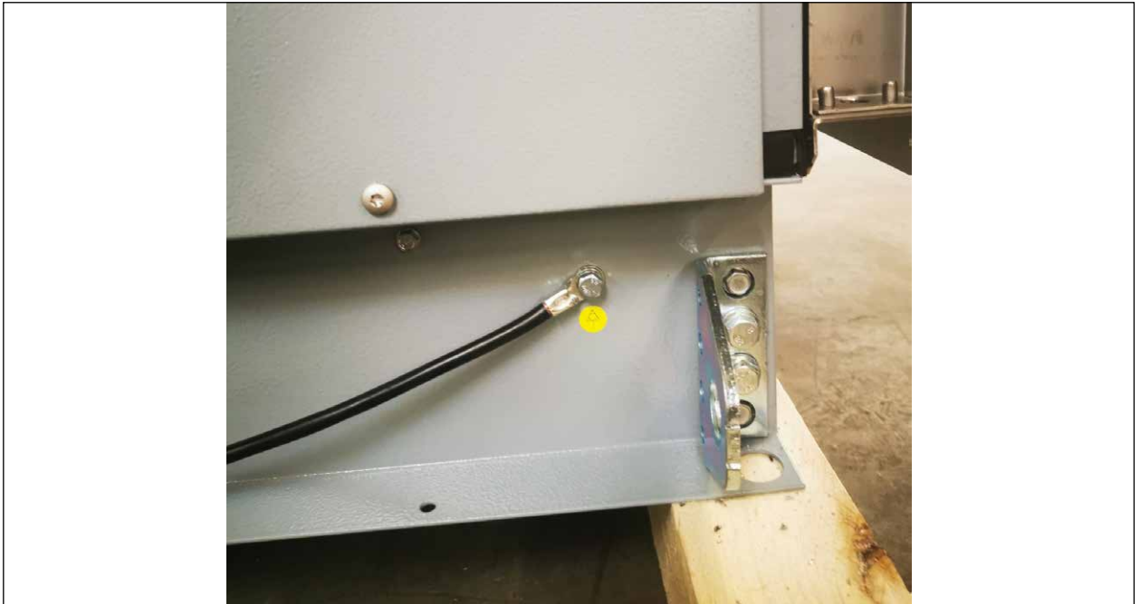
Afb. 15 Potentiaalaansluiting op het basisframe
