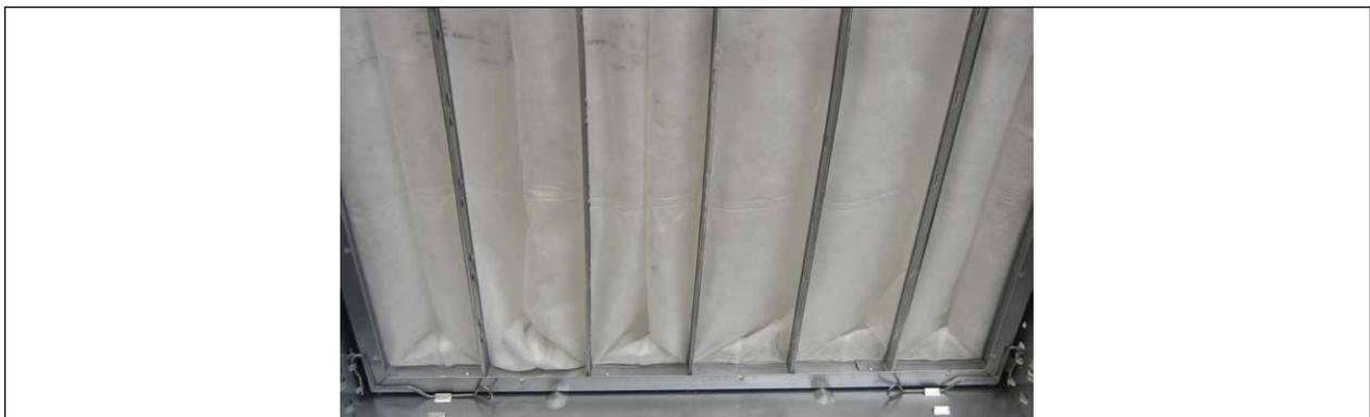
Abb. 37 Filteraufnahmerahmen mit Filterklammern
